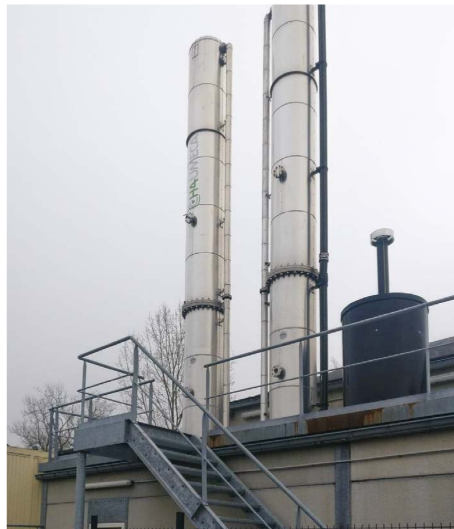
Figuur 3: Het biogas wordt via een waterwassing opgezuiverd tot groen gas
